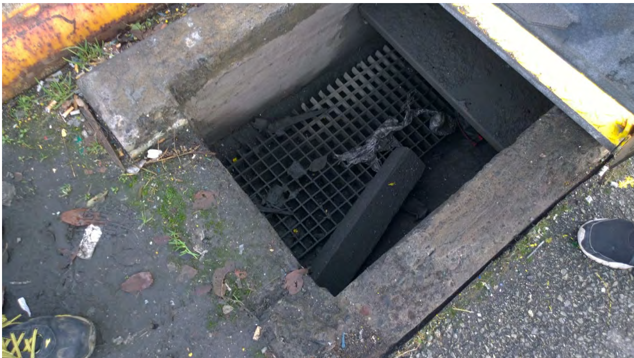
Mynd 2.2.2 Ónothæfur rafdreifibrunnur á vestari enda Miðbakka.
