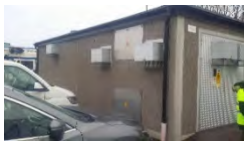
Mynd 4 Gautaborg Hús fyrir rafmangsbúnað
