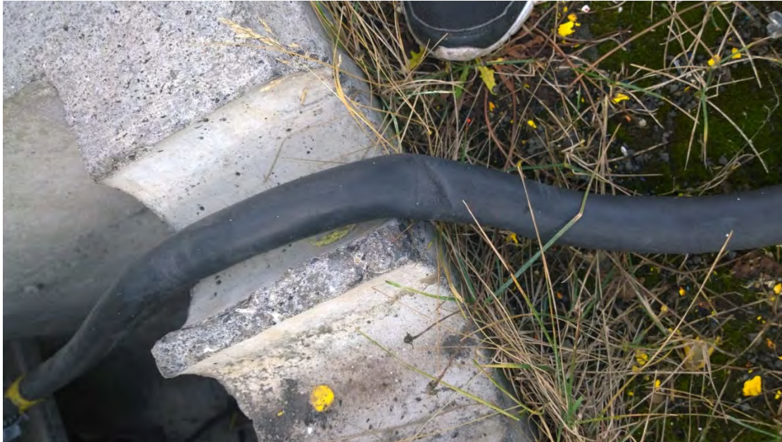
Mynd 3.2.4 Skarð að myndast í taug vegna stálloks.
