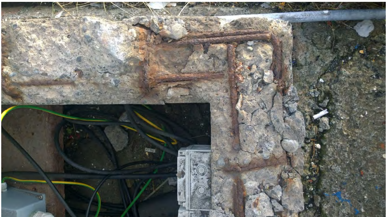
Mynd 1.2.2 Illa farinn rafdreifibrunnur á Ægisgarði.
