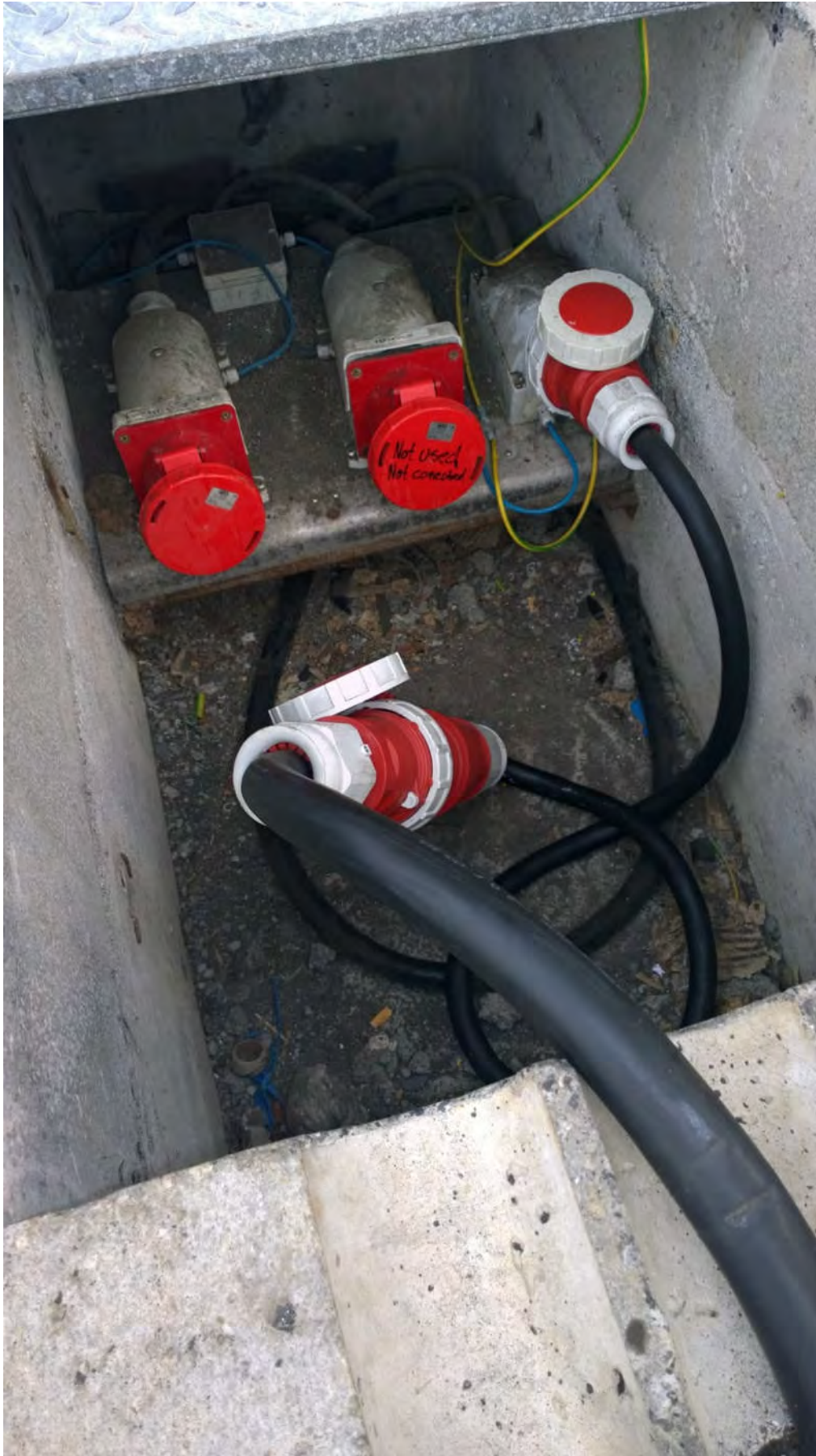
Mynd 3.3.2 Ótengdir tenglar í rafdreifibrunni á Austurbakka.
