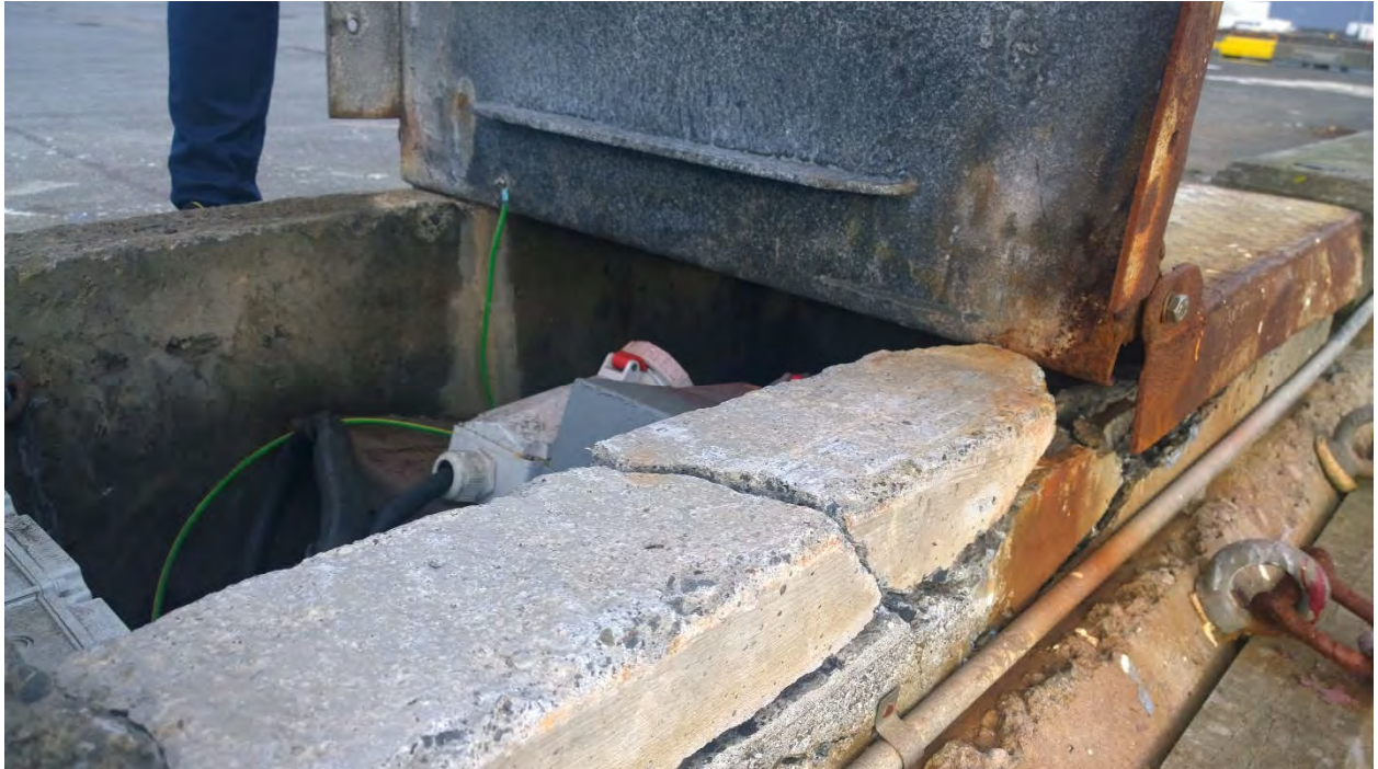
Mynd 1.2.3 Illa farin viðgerð á rafdreifibrunni á Ægisgarði.
