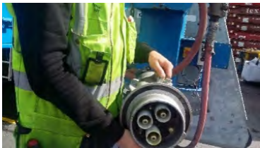
Mynd 26. Tengikló fyrir 11 kV. Ljósmynd GHS.
