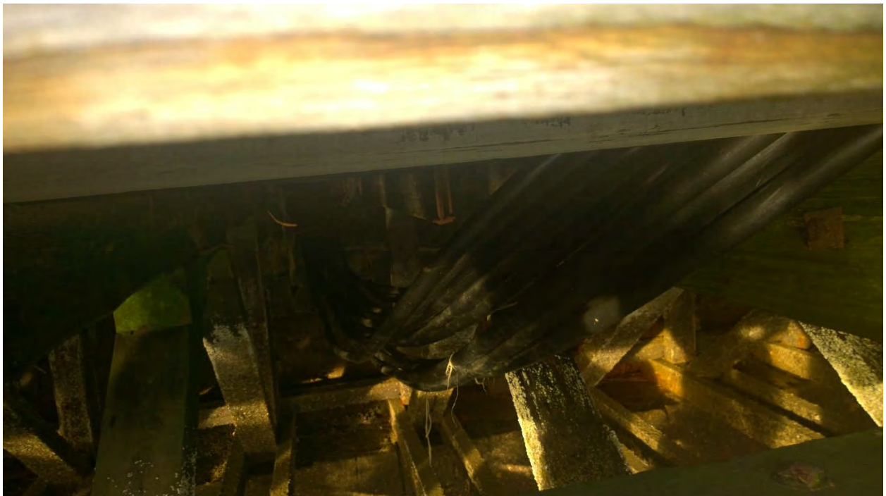
Mynd 1.3.1 Hangandi lagnaleiðir undir bryggjugólfinu.
