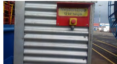
Mynd 28. Neyðarstopp fyrir 11kV. Ljósmynd GHS.
