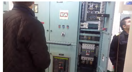
Rafmagnstafla fyrir landtengingu um borð í Nedim.
