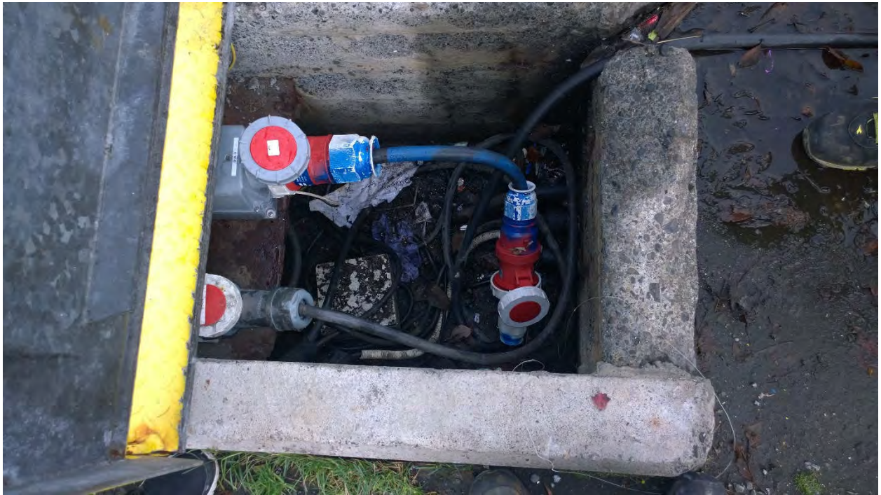
Mynd 2.2.1 Nothæfur rafdreifibrunnur á vestari enda Miðbakka.
