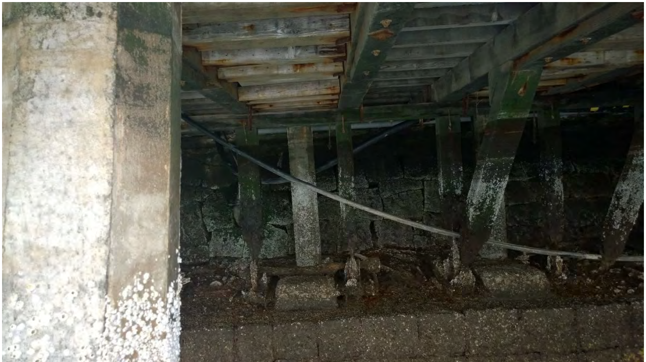
Mynd 1.3.3 Hangandi lagnir undir bryggjunni.
