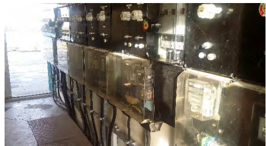
Mynd 16. Dreifi- og tengiskápar Ægisgarði 2019. Ljósmynd GHS.
