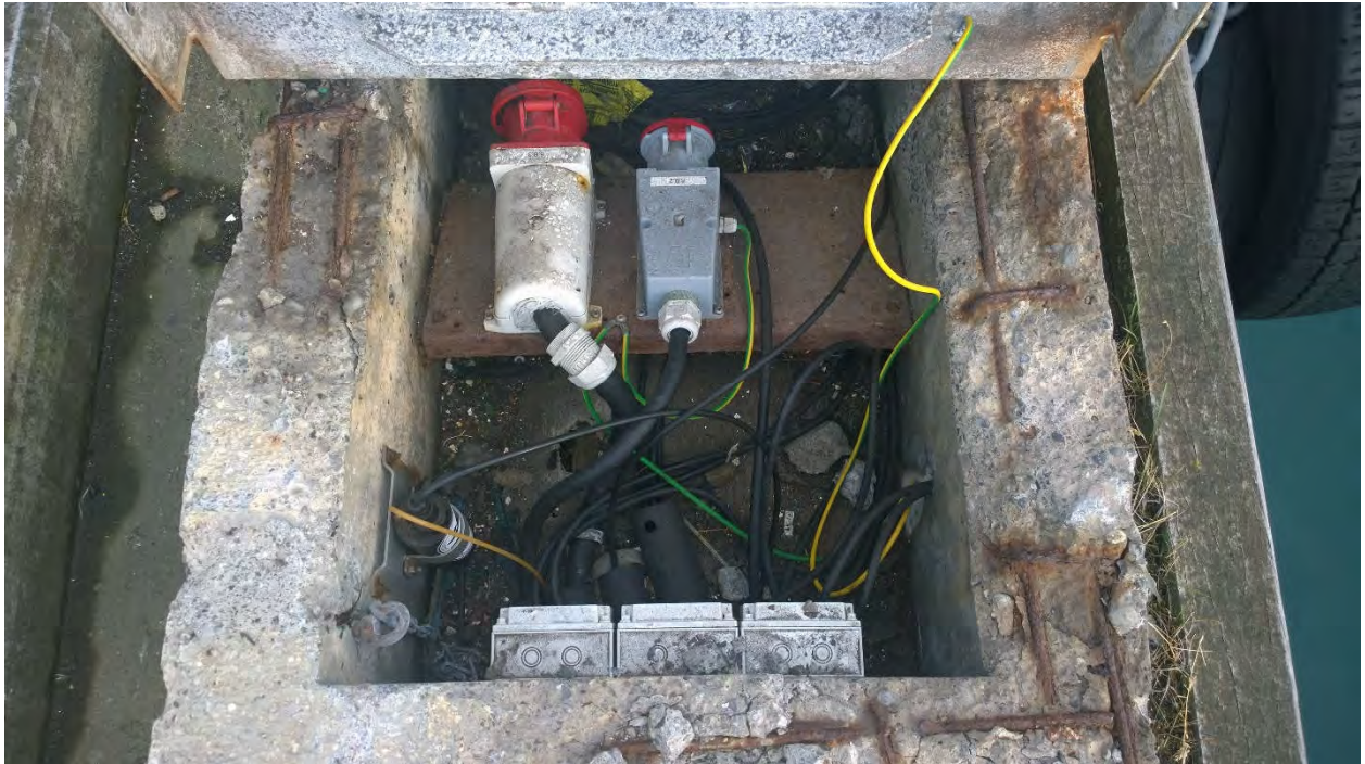
Mynd 1.2.1 Illa farinn rafdreifibrunnur á Ægisgarði.
