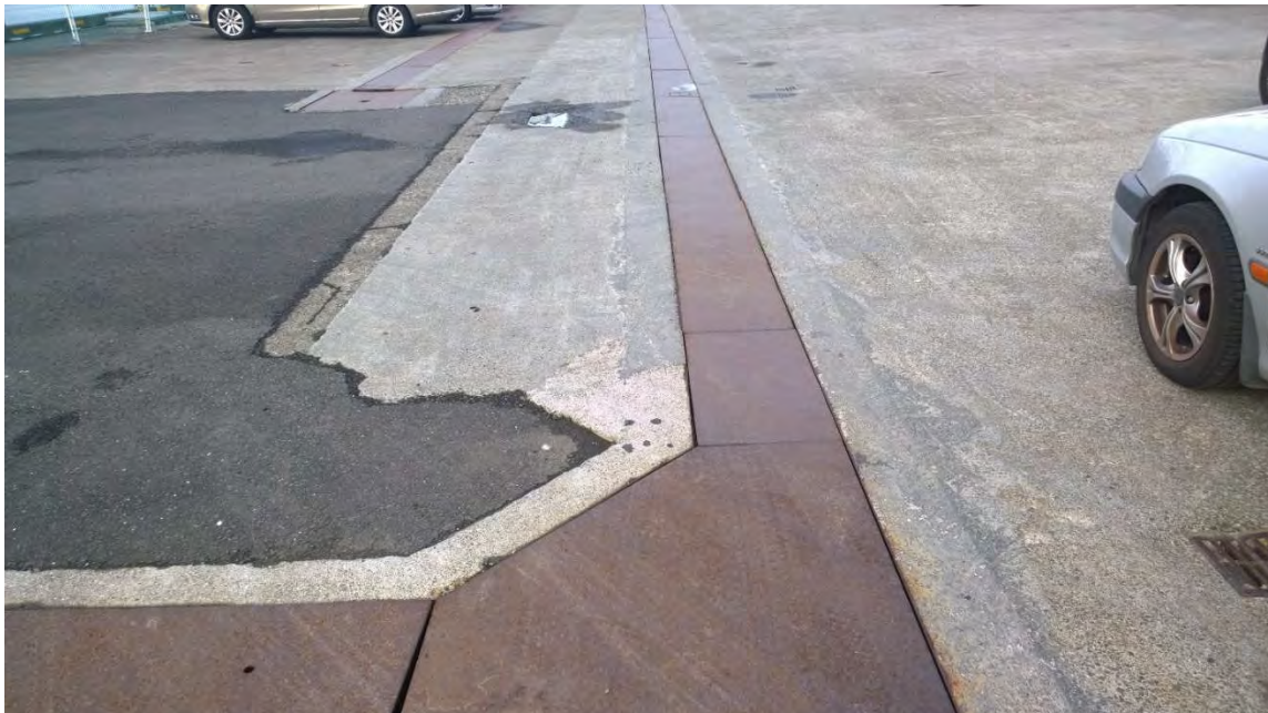
Mynd 3.3.1 Lagnastokkur í bryggjugólfi Faxagarðs.
