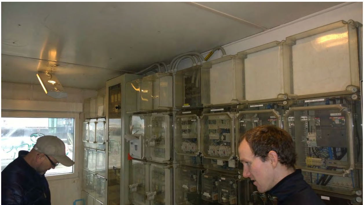
Mynd 3.1.2 Bráðabirgða rafdreifirými á Faxagarði og Austurbakka.
